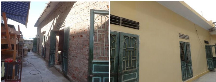
De buitenkant van de vertrekken voor en na de opknapbeurt. De deuren krijgen ook nog een nieuwe verfje.
